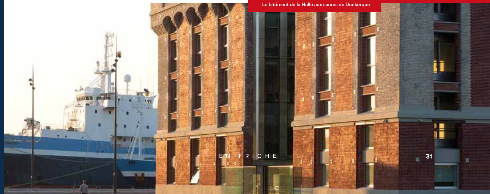
Le bâtiment de la Halle aux sucres de Dunkerque
