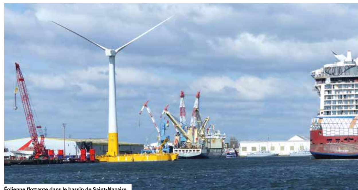
Éolienne flottante dans le bassin de Saint-Nazaire
