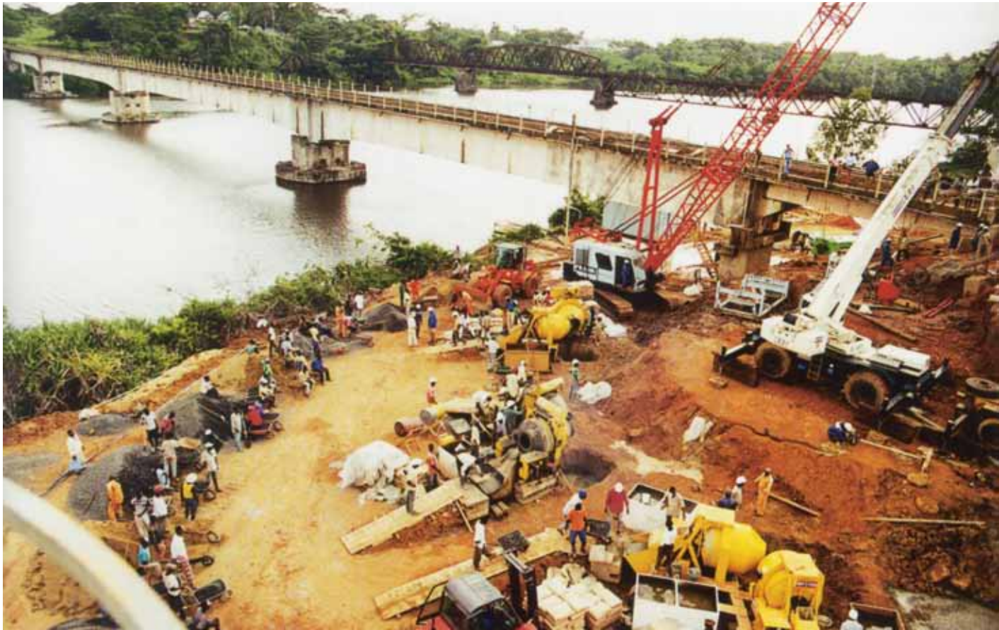
Travaux sur le pont au dessus de la rivière Dibamba
